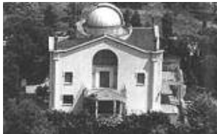
Vista exterior de l'observatori Esteve Duran
