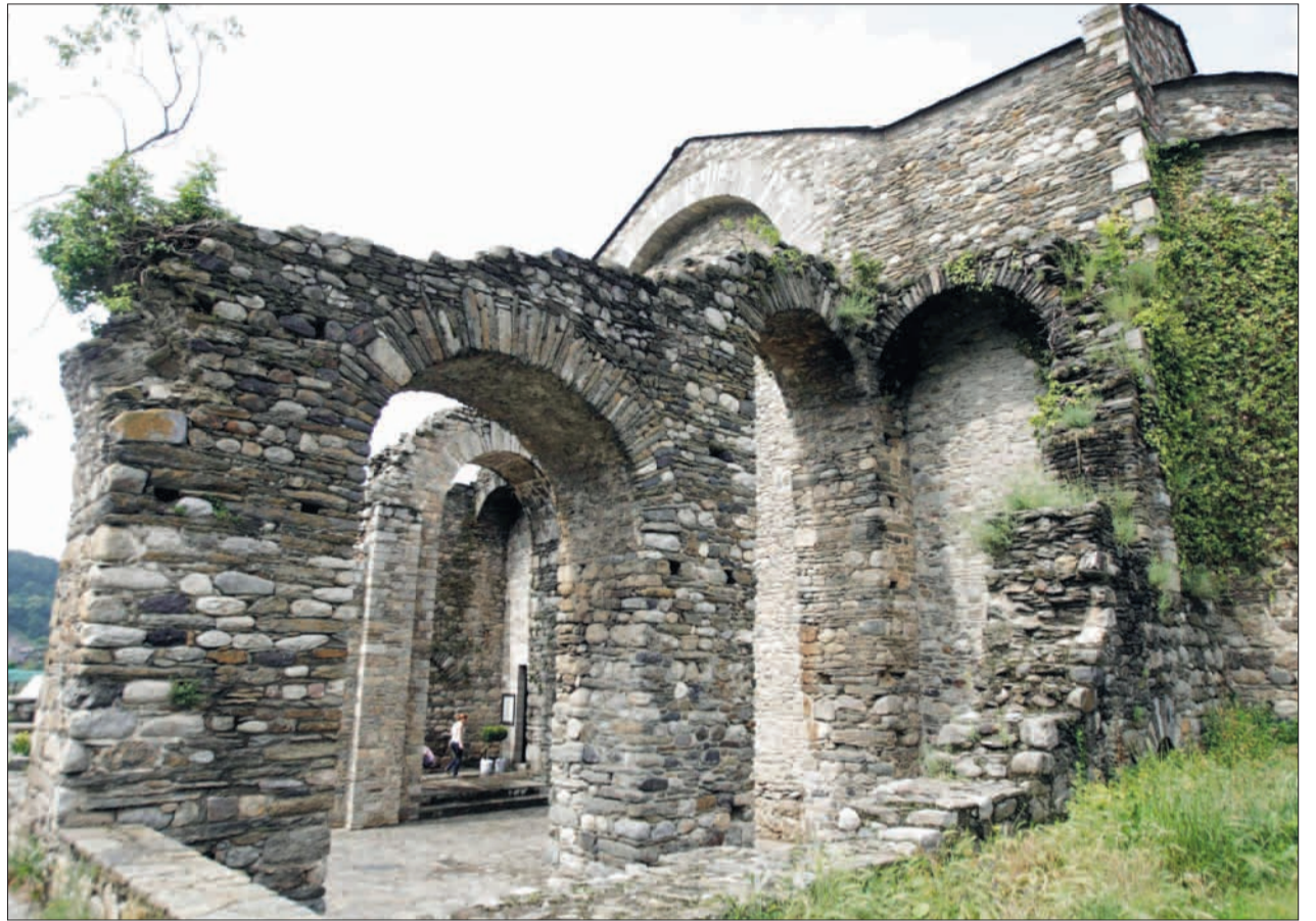
► Restes de les naus de Sant Serni, molt probablement ensorrades a conseqüència del terratrèmol del 1428.
