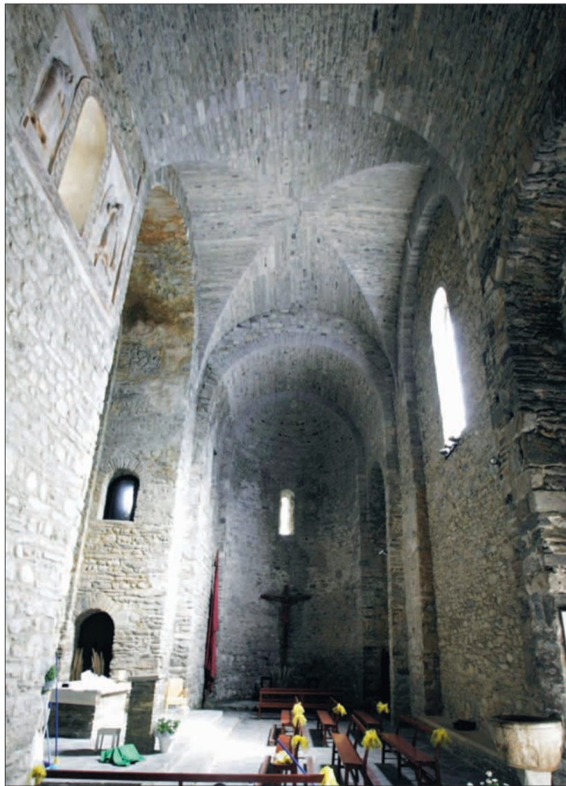
► Transsepte del temple; la volta, ara reconstruïda, no va resistir el sisme.
